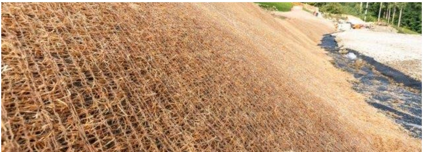
Abb. 8: Mit schweizer Holzwollevliesen belegte Böschung in der Ostschweiz (vorher). Fig. 8 : Talus recouvert de nattes en laine suisse de bois en Suisse orientale (avant).
