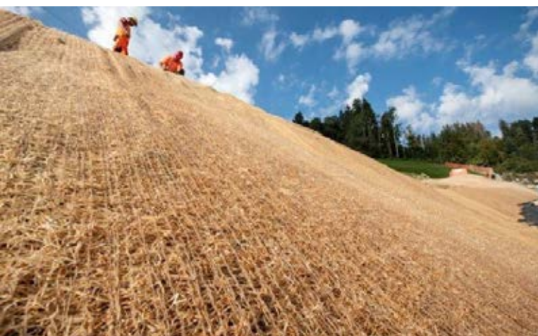
Abb 6.: Die Holzwollevliese werden mit Holzhaften befestigt. Fig. 6 : Les tapis en laine de bois sont fixés à l'aide d'attaches en bois.
