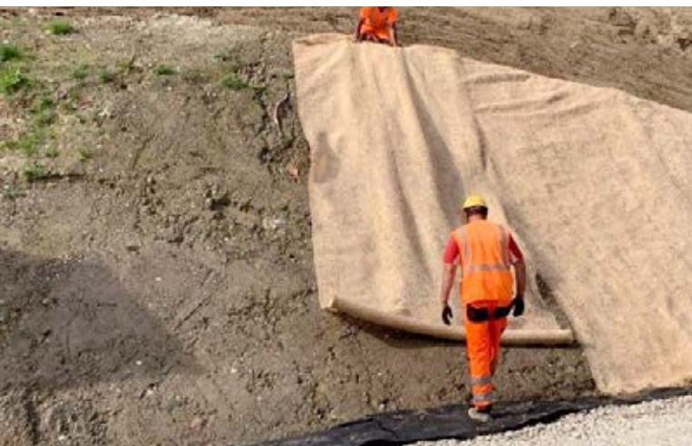
Abb 4: Verlegen der Erosionsschutzvliese an einer Böschung. Fig. 4 : Pose d'une natte de protection contre l'érosion sur un talus.
